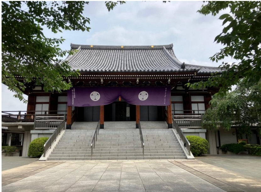
「傳通院(東京都文京区小石川 3-14-6)」 ©2026・6 川端紅葉 東京ドームや後樂園から徒歩圏内にある
